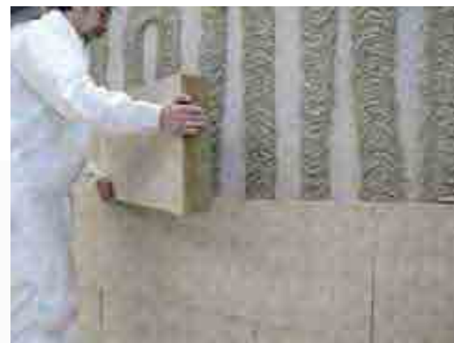
Anbringen einer mineralischen Wärmedämmung auf ein bestehendes Gebäude
