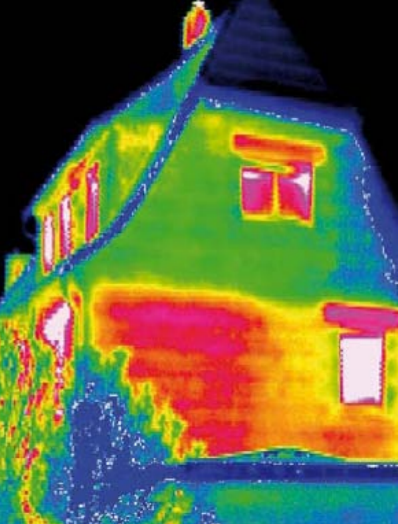
Thermografie vor der Sanierung
